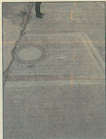
EMPATE DE POZOS Y DILATACIONES CON PAVIMENTO
