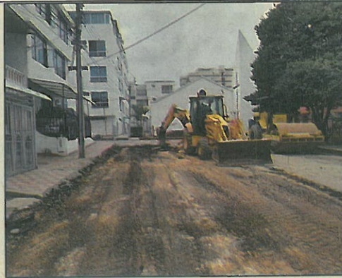
DEMOLICION Y RETIRO DE CARPETA ASFALTICA
