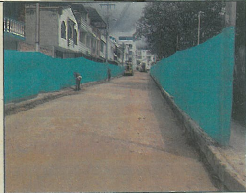
CONFORMACION DE ESTRUCTURA GRANULAR PARA PAVIMENTO
