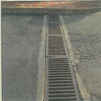
SUMIDERO TRANSVERSAL INSTALADO Y EN FUNCIONAMIENTO
