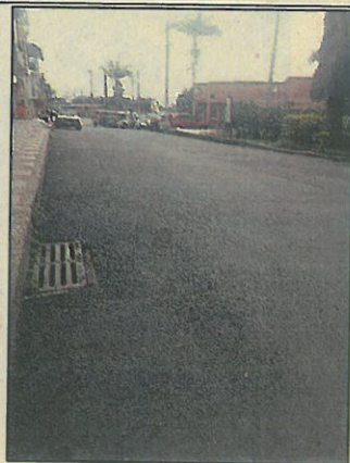
SUMIDEROS LONGITUDINALES INSTALADOS
