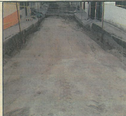
RELLENO DE MATERIAL TIPO SIBBASE Y COMPACTACION
