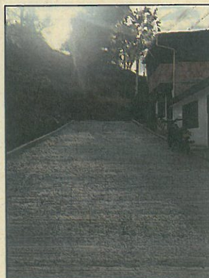
PAVIMENTO EN CONCRETO TERMINADO Y ACABADO TIPO ESTRIADO
