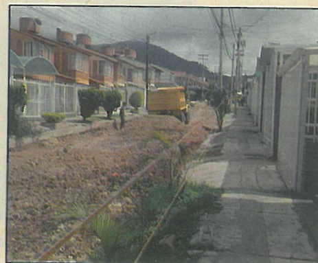
RELLENO EN MATERIAL GRANULAR TIPO SUBBASE
