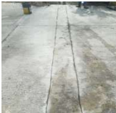
Imagen 1. Corte con disco diamantado Reposición red \phi 2" Comuna Sur - oriental
