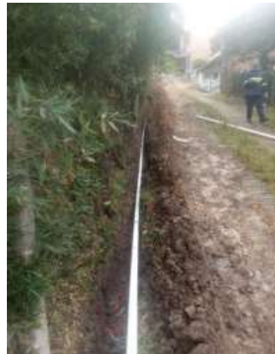
Imagen 4. Expansion Tubería 2" sector Comuna Sur-oriental
