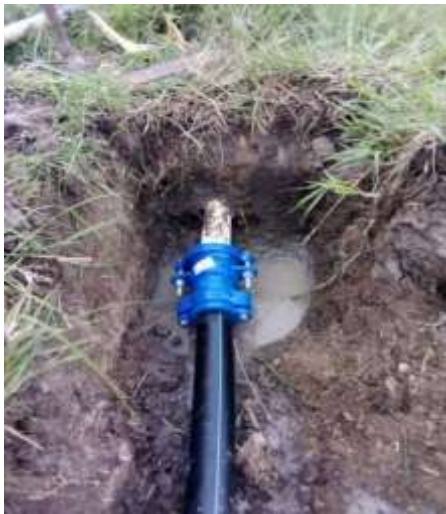
Imagen 3. Expansion Tubería \phi 2" sector fusacatan
