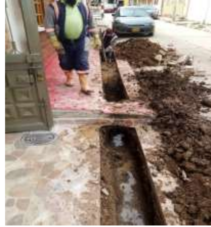
Imagen 4. Expansion Tubería 2" sector Comuna Sur-oriental
