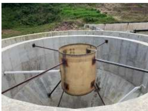
FOTO 9. TANQUE ESPESADOR DE LODOS
