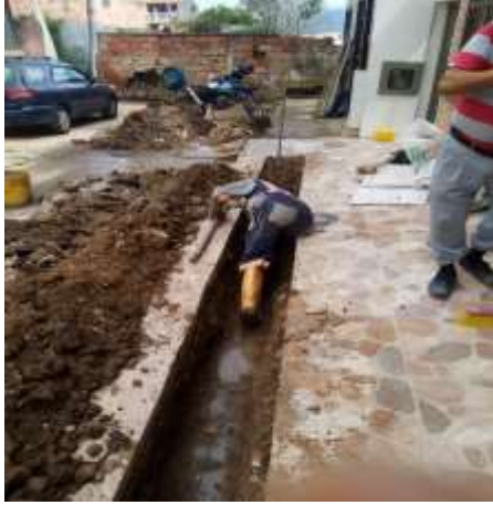
Imagen 3. Expansion Tubería \phi 2" sector fusacatan
