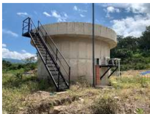
FOTO 10. TANQUE ESPESADOR DE LODOS
