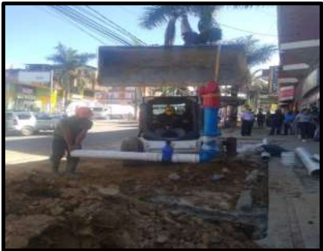
Imagen 3. Instalación de tubería de 30". Contrato 063-20.
