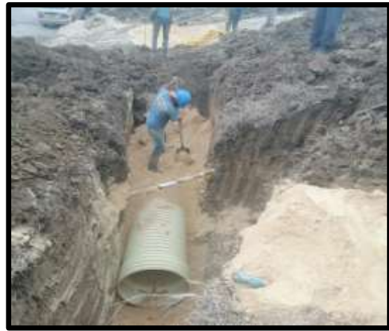
Imagen 2. Instalación de tubería de 30". Contrato 063-20.
