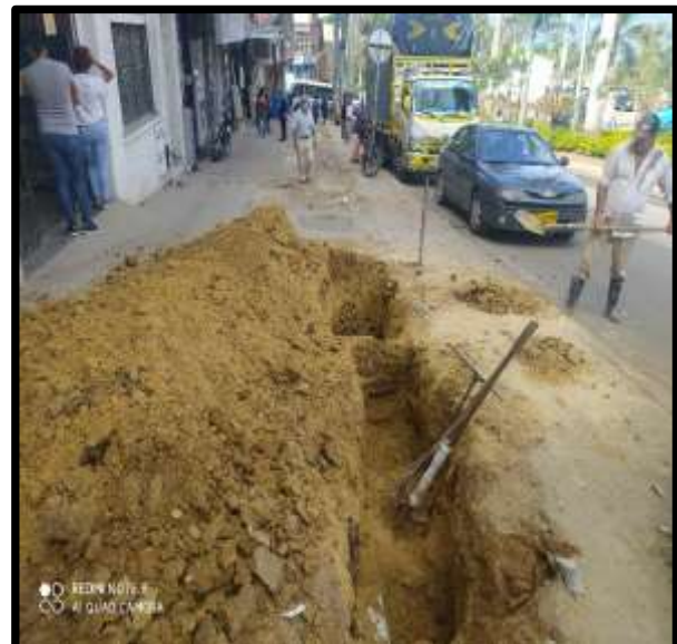
Imagen 8. Excavación para tubería. Contrato No. 082-2020.
