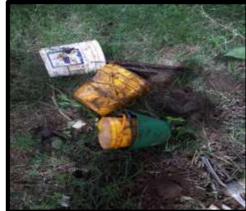
Retiro de material de taponamiento
