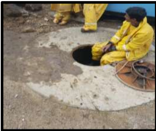
Limpieza tubería de 30" línea Cuja
