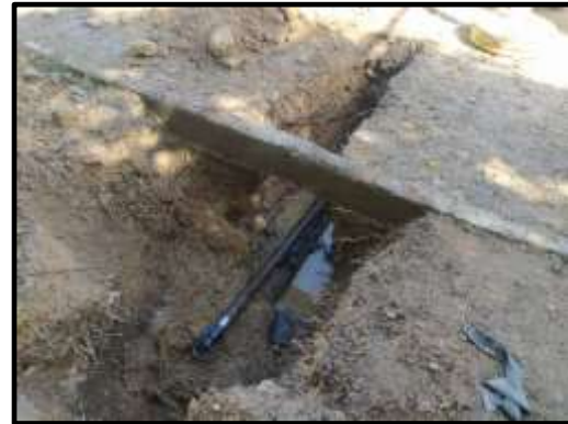
Imagen 10. Perforación dirigida tubería polietileno 6". Contrato No. 082-2020.
