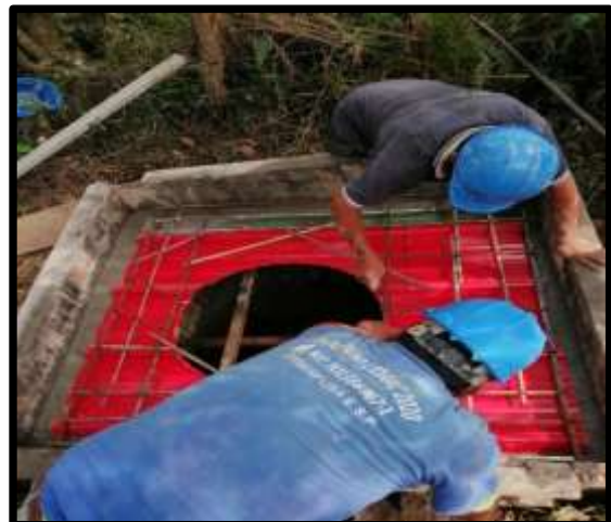
Imagen 4. Instalación Cajs de inspeccion. Contrato 063-20.
