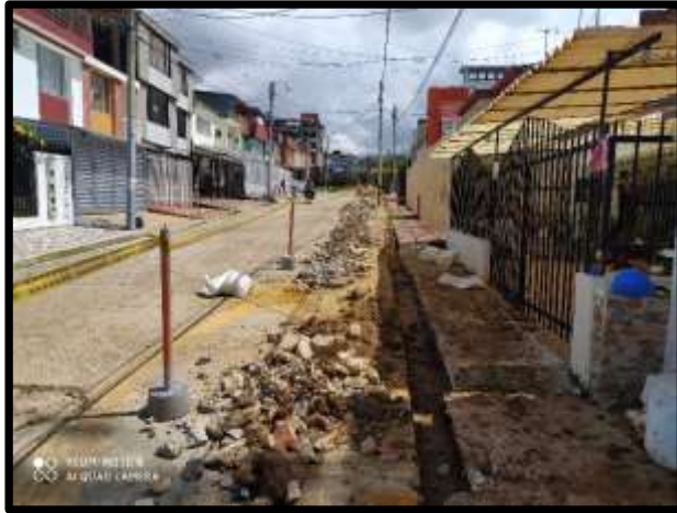
Imagen 11. Excavacion para instalacion tuberia. Contrato No. 122-2020.
