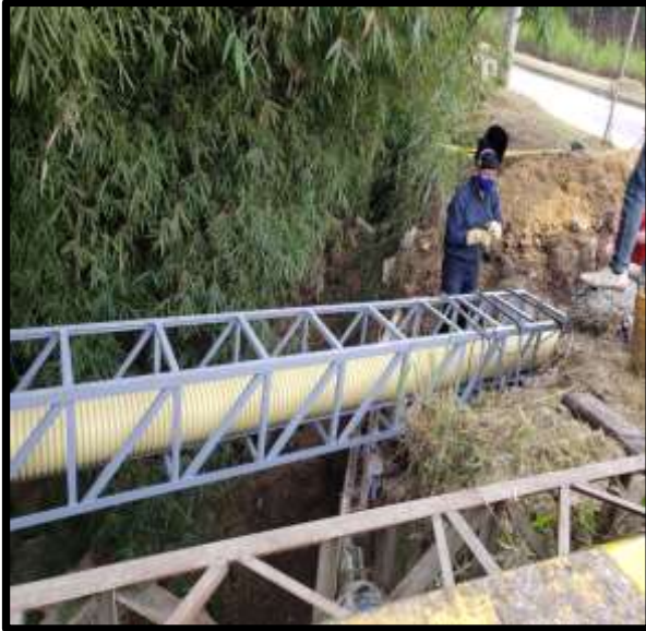
Imagen 7. Instalación cercha y tubería. Contrato No. 082-2020.
