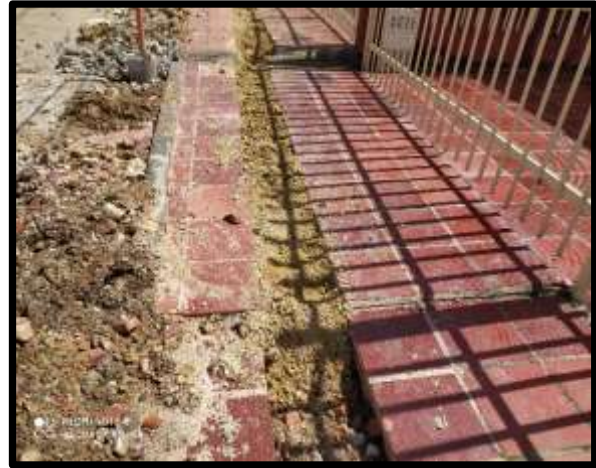
Imagen 12. Relleno en recebo común compactado. Contrato No. 122-2020.
