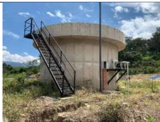
FOTO 10. TANQUE ESPESADOR DE LODOS
