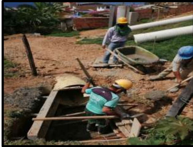
Imagen 3. Instalación de tubería de 30". Contrato 063-20.
