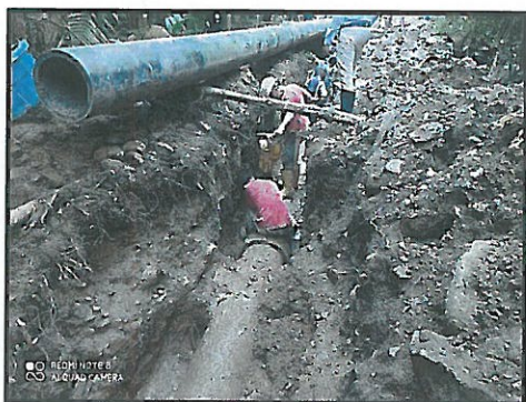
Fotografía No 27 Empate tubería Polietileno PE-100
