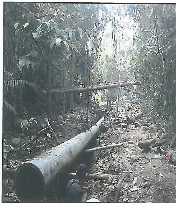
Fotografía No 16 Instalación Tubería Polietileno PE-100
