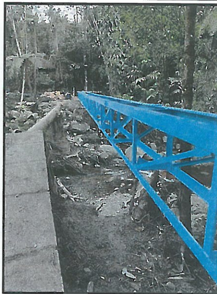
Fotografía No 24 Instalación Cercha
