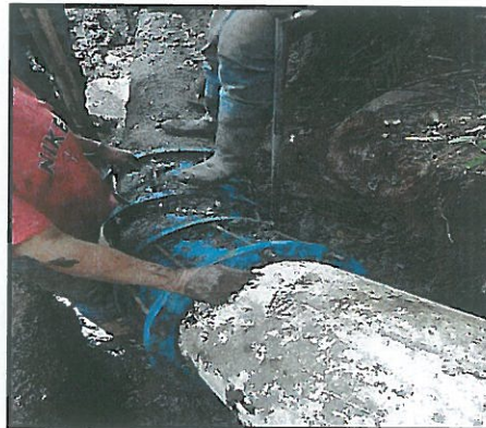
Fotografía No 28 Empate tubería Polietileno PE-100
