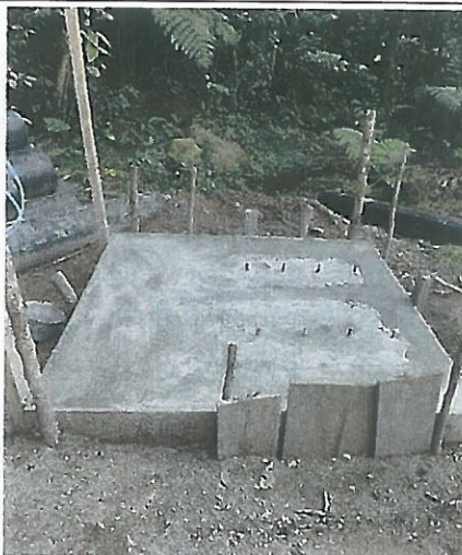
Fotografía No 22 Zapatas en concreto
