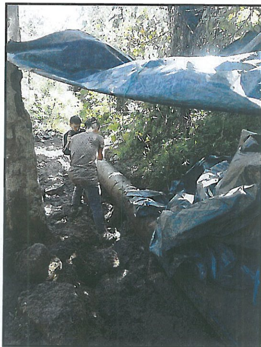
Fotografía No 15 Suministro Tubería Polietileno PE-100
