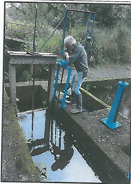
Fotografía No 6 Mantenimiento Compuerta Rectangular
