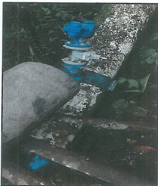
Fotografía No 29 Empate tubería Polietileno PE-100
