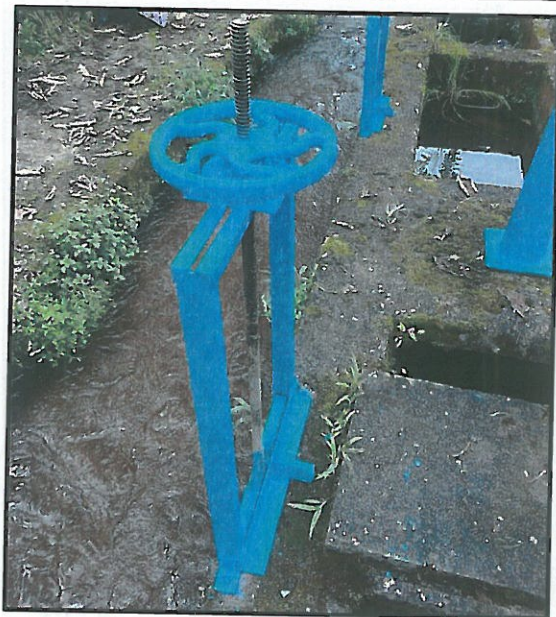
Fotografía No 5 Mantenimiento Compuerta
