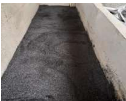
Fig.9 Suministro e instalacion de carbon activado
