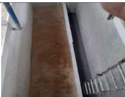
Fig.11 Suministro e instalacion capasa de arena fina
