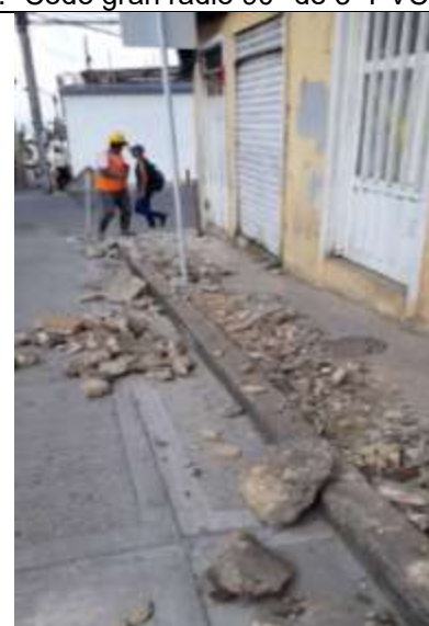
Fig.16. Demolición placa 10 cm
