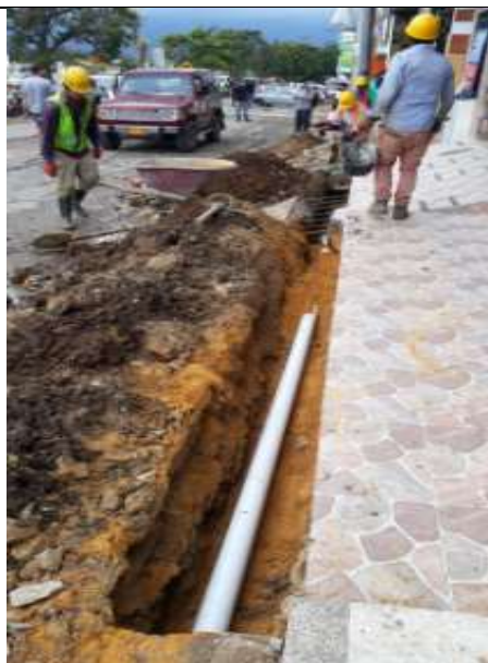
Fig.22. Instalación de tubería 3" UM
