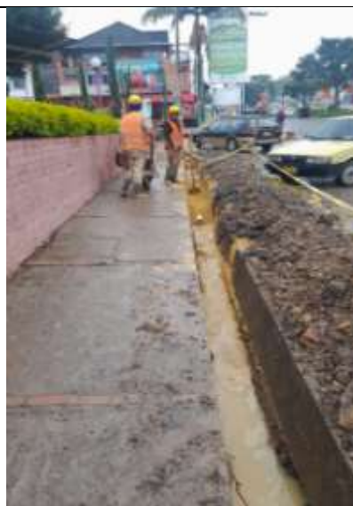
Fig.20. Excavación manual en conglomerado
