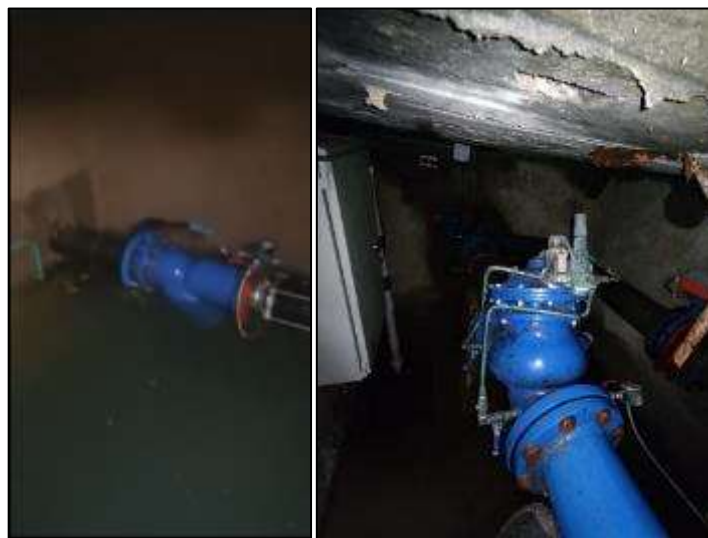
Estaciones reguladoras antes y después de cambio de motobomba.
