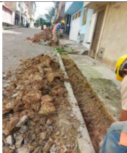
Fig.20. Excavación manual en conglomerado
