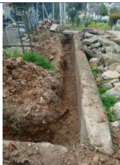
Fig.18. Demolición placa 15 cm
