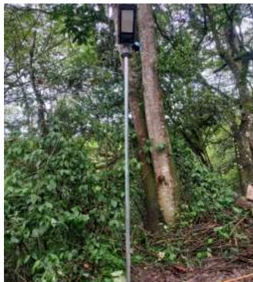
Fig. 16. Lamparas led con fotocelda.
