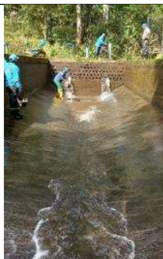
Fig.2. Limpieza de desarenadores.
