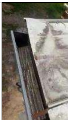
Imagen 13. Limpieza de las bajantes del banco de medidores
