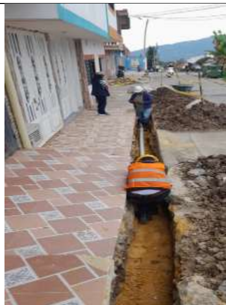
Fig.10. instalación de tubería PVC RDE 21 de 3"
