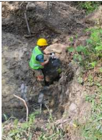
Fig.2. Excavación manual en roca h=0.-2.0 m (seco sin explosivos)
