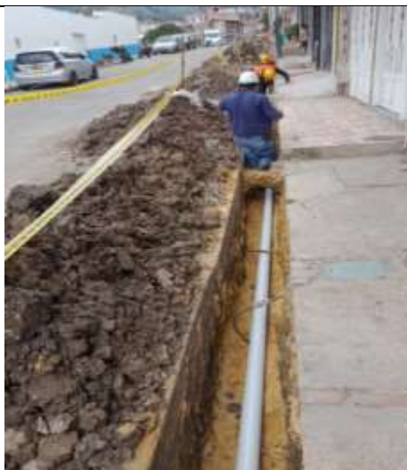
Fig.5 Suministro e instalación de tubería de 3" PVC union mecanica RDE 21
