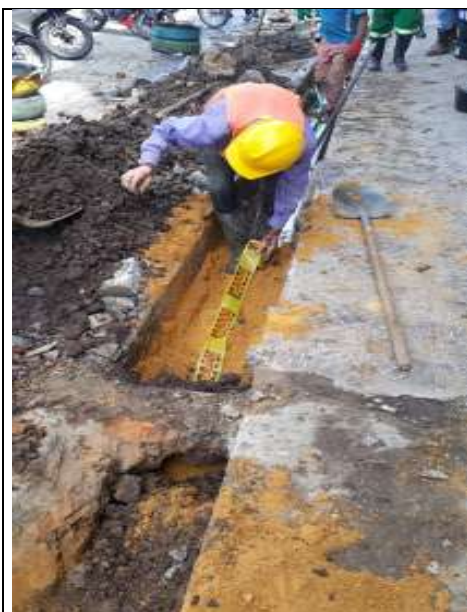
Fig.25. Base y atraque en arena
