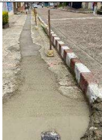
Fig.9. Expansión redes PVC 2” Fusacatán.- CO 104-2021
