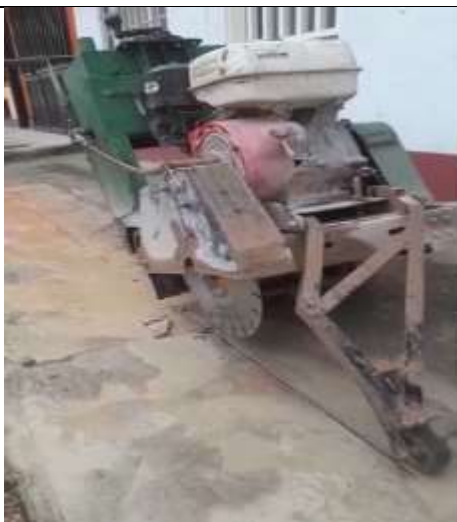
Fig.7. Corte con disco diamantado andén en concreto e \leq 0,10
