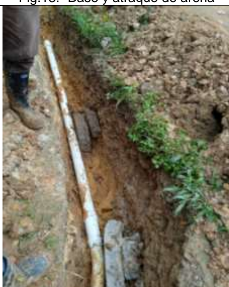
Fig.15. Unión pasante con campana 3" PVC RDE 21
