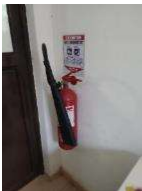
Imagen 11. Instalación del extintor multipropósitos
