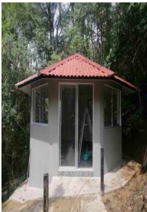
Fig.11. Suministro e instalación carpintería aluminio
