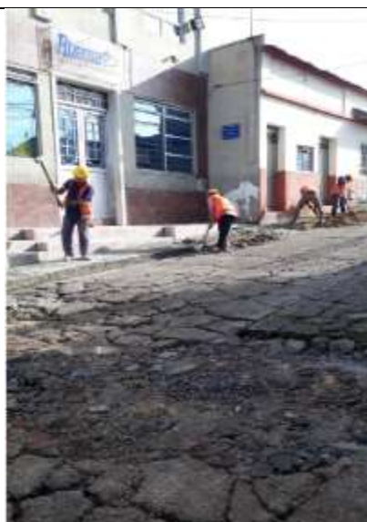
Fig.17. Demolición placa 10 cm
