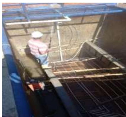
Fig.13 Lavado y desinfeccion de las estructuras existentes
