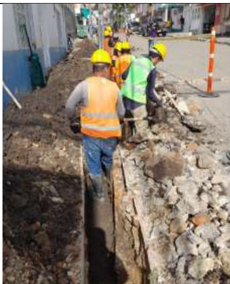
Fig.9. Excavación en material conglomerado
