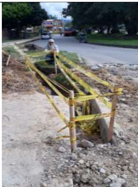
Fig.21. Excavación manual en roca
