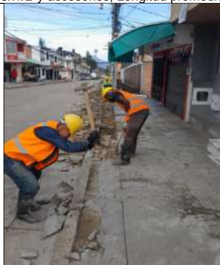
Fig.8 Demolición de andén en concreto e \leq 0,10
