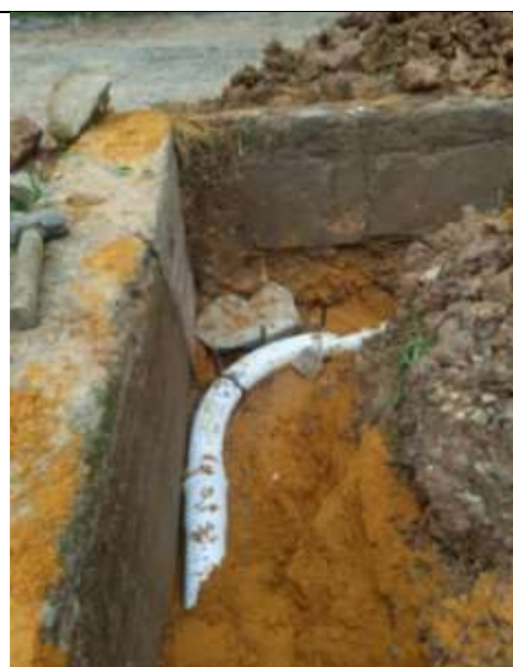
Fig.14. Codo gran radio 90° de 3" PVC RDE 21
