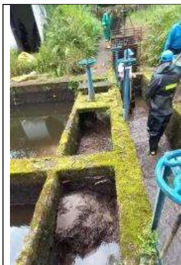
Fig. 1. Canal saturado de lodo y material agregado.
