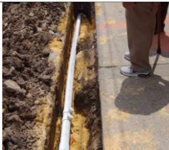
Fig.6. Reposición acometida domiciliaria de 1/2". Suministro e instalación. (Incluye tubería PF D= 1/2", registros, collar de derivación 3x1/2"y accesorios, Longitud promedio hasta 3 m)
