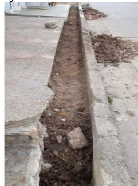
Fig.23. Relleno en material común
