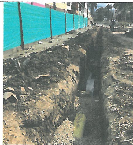
Instalación colector principal.
