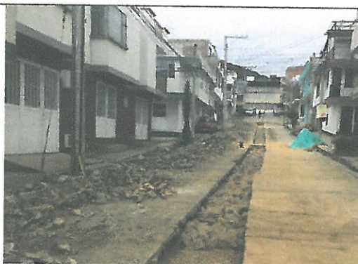
Instalación de acometida y atraque en gravilla
