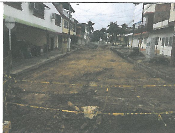
Nivelación de la vía en recebo compactado
