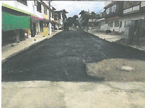
Nivelación de pozos de inspección
