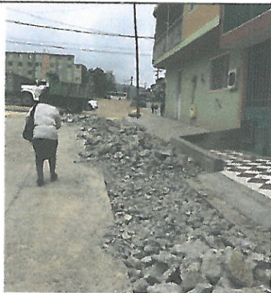
Corte del pavimento rígido
