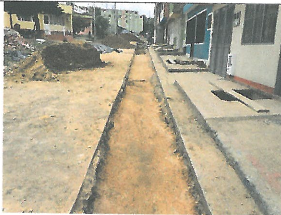
Nivelación de la vía en recebo compactado.
