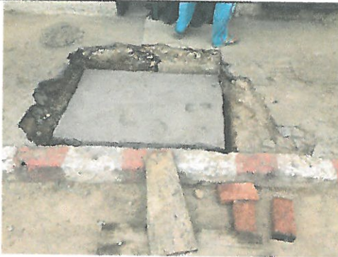
Instalación de tapas para las cajas de inspección.
