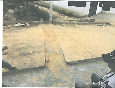
Nivelación de la vía en recebo compactado.
