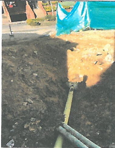
Instalación de acometidas en 6" PVC acanalada.
