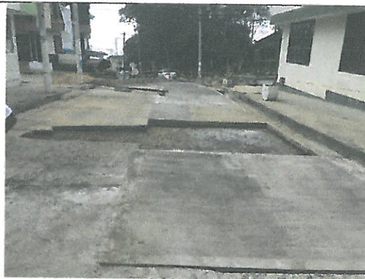
Recuperación de la vía en concreto para pavimento rígido
