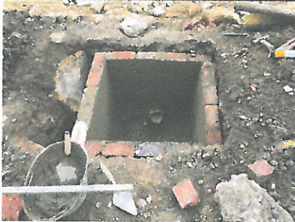
Construcción de cajas de inspección de 0.8x0.8x0.8
