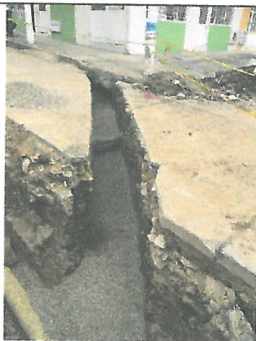
Instalación de acometida y atraque en gravilla
