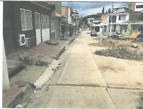
Reposición de la vía en concreto para pavimento rígido
