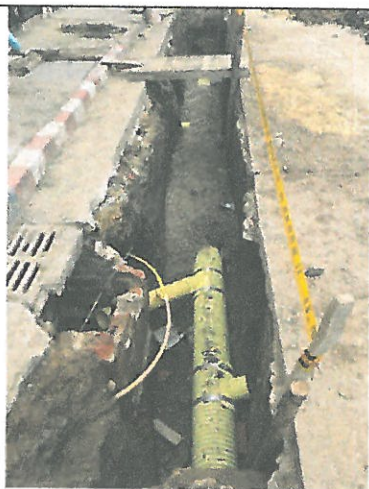
Instalación del colector principal, y acometidas en PVC acanalada, con atraque en gravilla.
