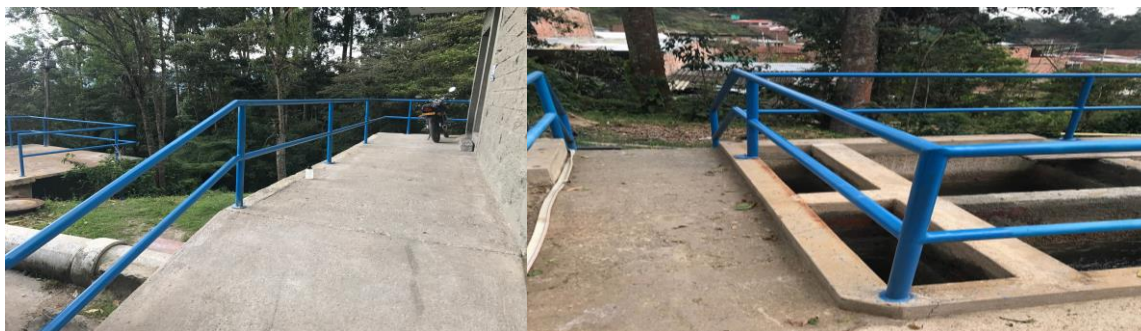
Instalación de barandas de seguridad en las Plantas
