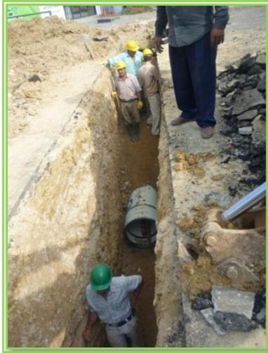
*Se observa instalación de tubería de 30" a 3 m de profundidad.*
