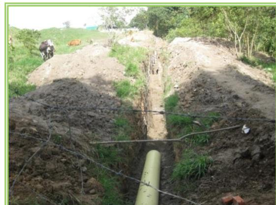
*Instalación de tubería de 16" PVC*
