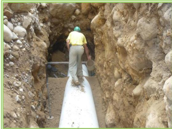
*Instalación de tubería con recebo.*
