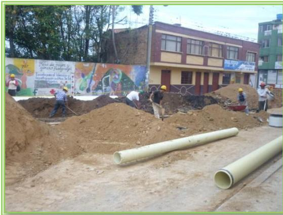
*Se observa obras realizadas sobre la Carrera 9 reposición de 48 m de tubería que se presentaba taponamientos y ya había Cumplido su vida útil.*
