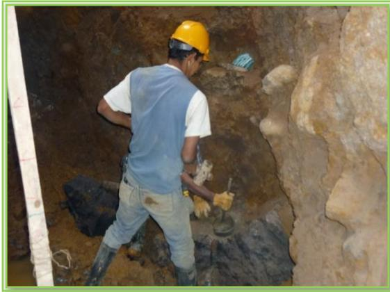
*Se observa la perforación en roca con taladros para detonación con pólvora negra*
